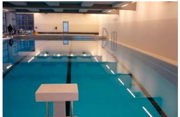
Sanierte Schwimmhalle in Grosshöchstetten
